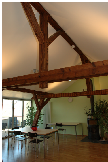
Dachstock der Wohngruppe Murbacher- strasse
